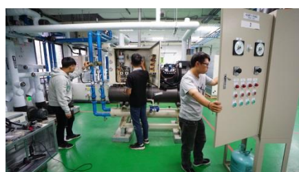
冷凍空調國家技能檢定考場
